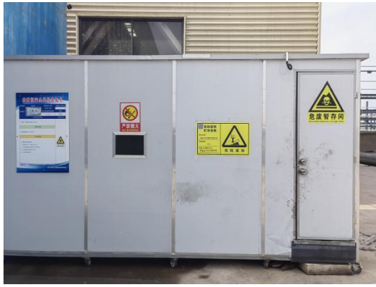
危险废物暂存间
