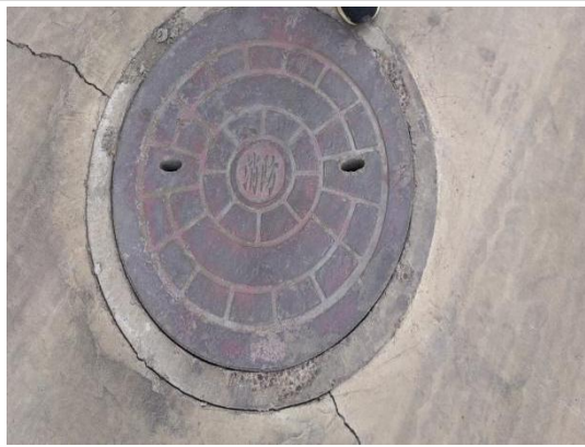
固定式消防系统
