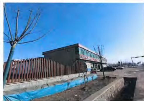
平杨线北侧的门脸处
