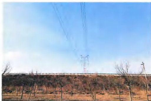
线路跨越迁安支线
