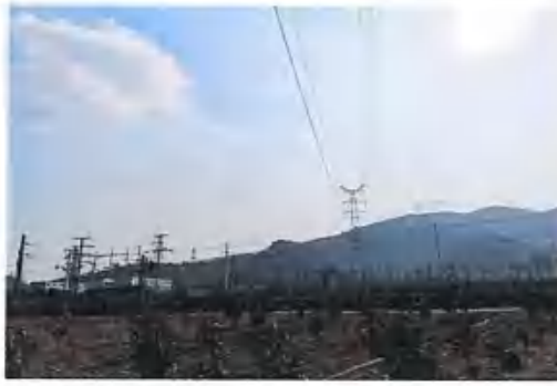
线路跨越铁路干线
