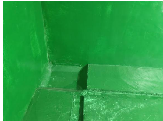
危废间集液池
