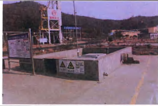
油相制备-复合油储罐
