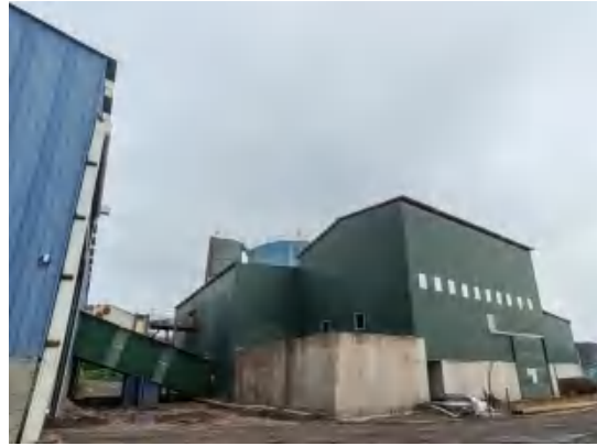
尾矿干排车间
