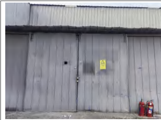
危险废物暂存间
