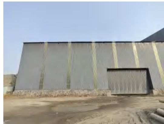
封闭尾矿砂库房
