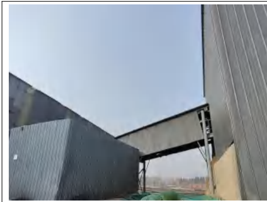
封闭皮带通廊
