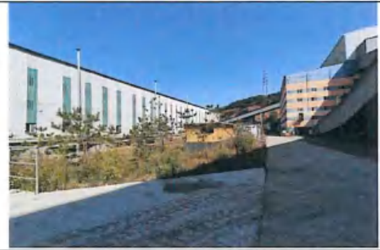
厂区地面硬化
