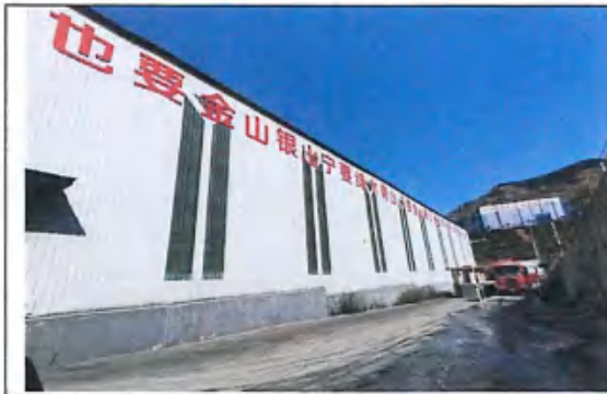
封闭铁精粉库房
