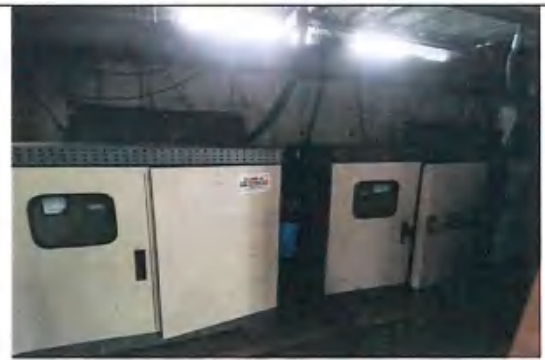
铁精粉库房喷雾
