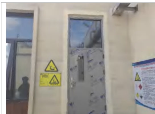
危险废物暂存间
