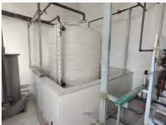
储罐围堰
