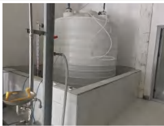
储罐围堰
