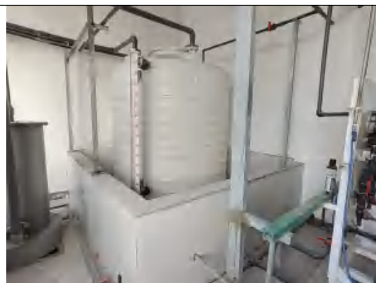
储罐围堰
