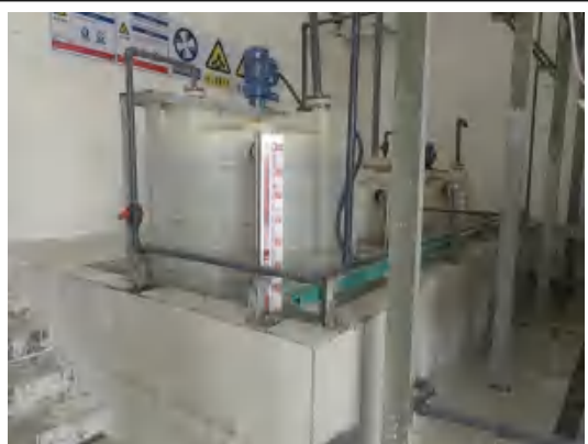
储罐围堰
