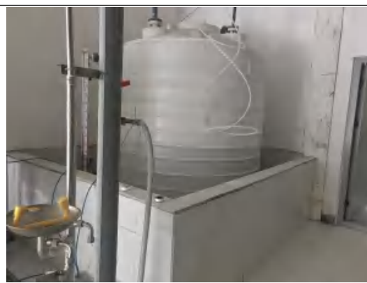
储罐围堰
