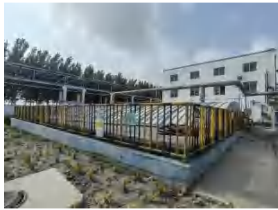
初期雨水收集池
