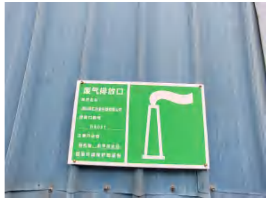
排放口标识牌
