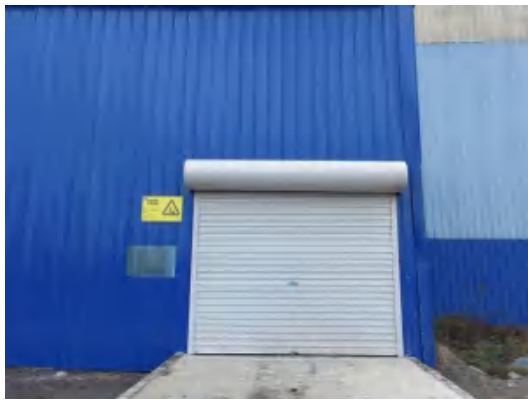
危险废物暂存间
