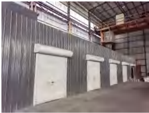
预混、混炼工序二次封闭
