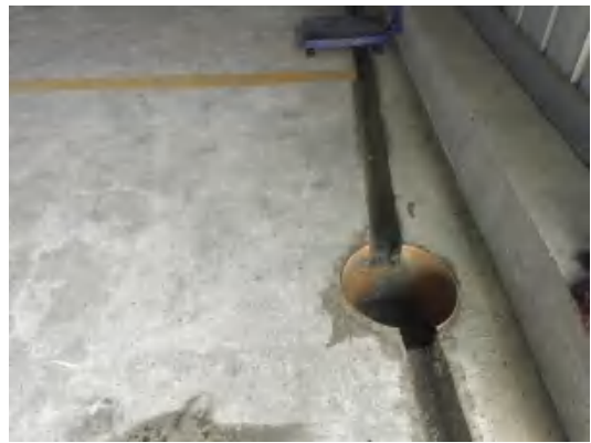
地面导流沟及集液池
