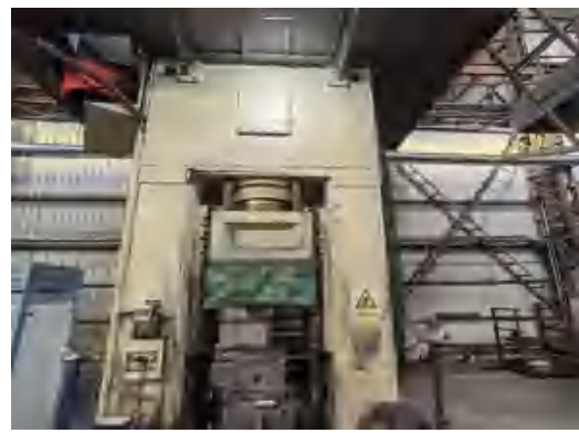
压力机集气管道
