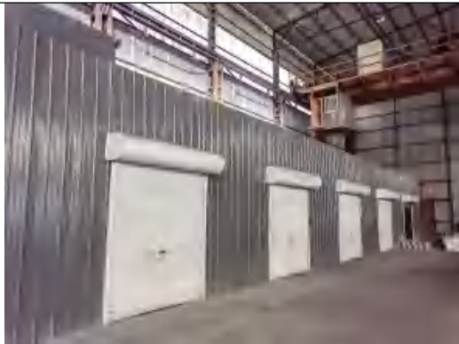
预混、混炼工序二次封闭
