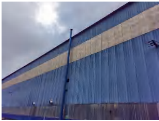
磨平废气除尘器排气管
