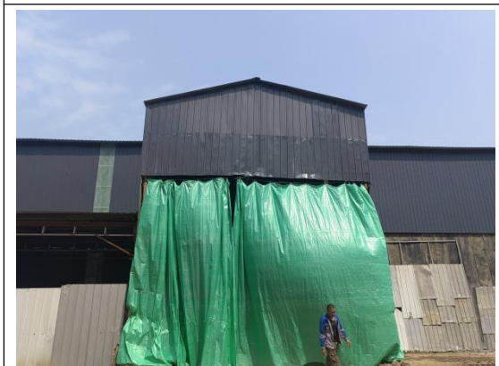
封闭入料棚(三面围挡+软帘)
