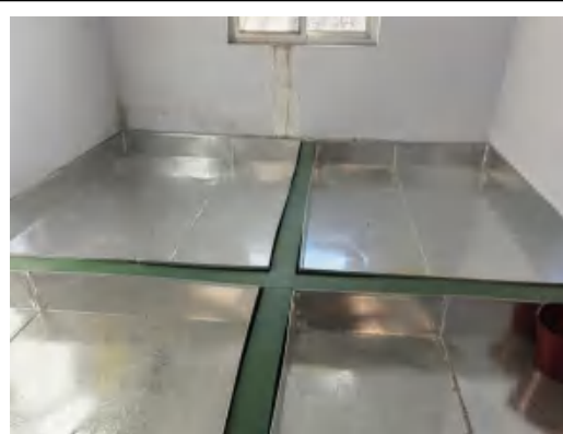
2#危险废物暂存间分区
