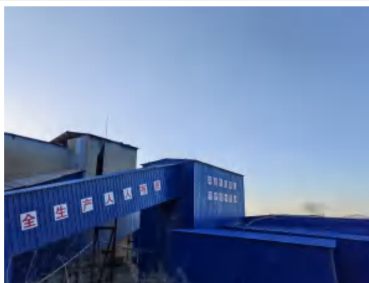
1#废料综合利用系统厂房隔声
