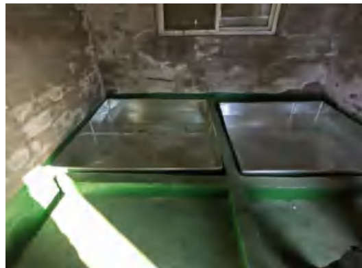
1#危险废物暂存间分区
