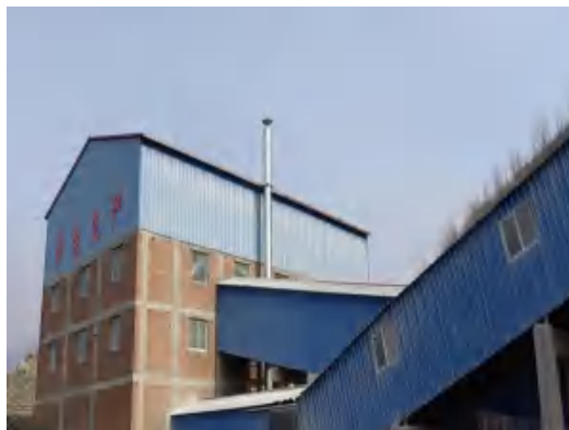
2#废料综合利用系统厂房隔声
