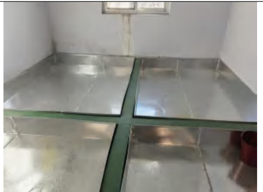
2#危险废物暂存间分区
