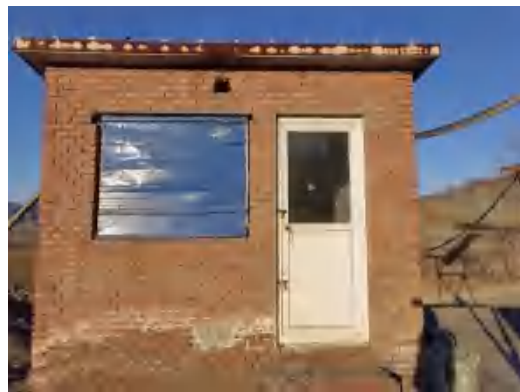
1#危险废物暂存间
