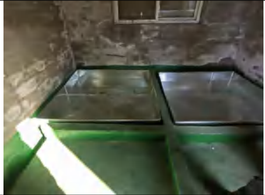
1#危险废物暂存间分区
