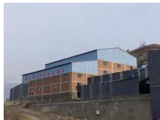
2#废料综合利用系统厂房隔声
