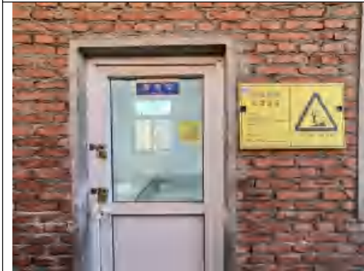
2#危险废物暂存间
