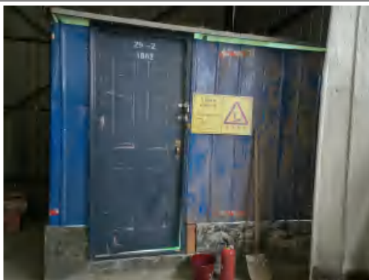
危险废物暂存间
