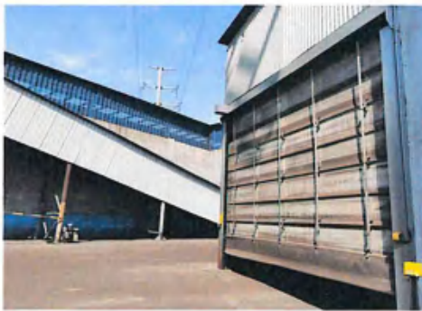
110kV 焦联线-汽车修理站
