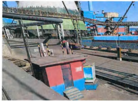
110kV 焦联线-5#-6#塔磅房
