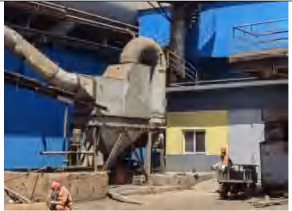
生石灰消化工序高效湿式除尘器
