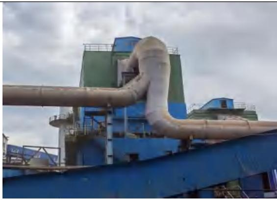
烧结机机尾脉冲布袋除尘器
