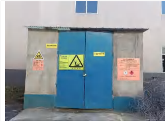
危险废物暂存间
