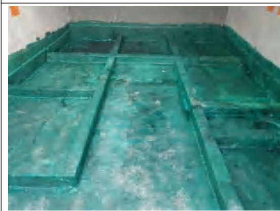
危废间地面防渗+分区设置
