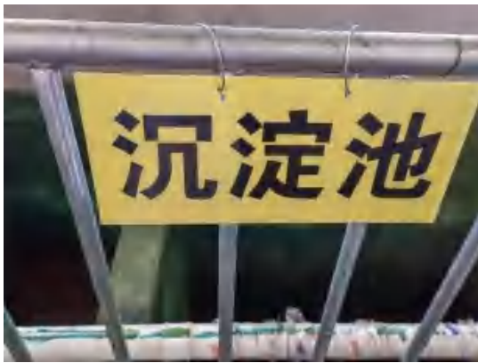
污水处理站沉淀池
