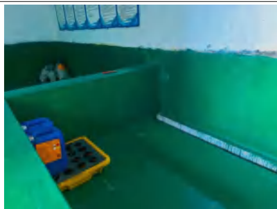
危废间内地面分区
