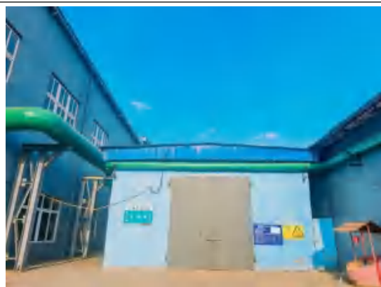
危险废物暂存间
