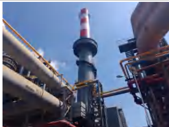
热风炉烟气排气筒
