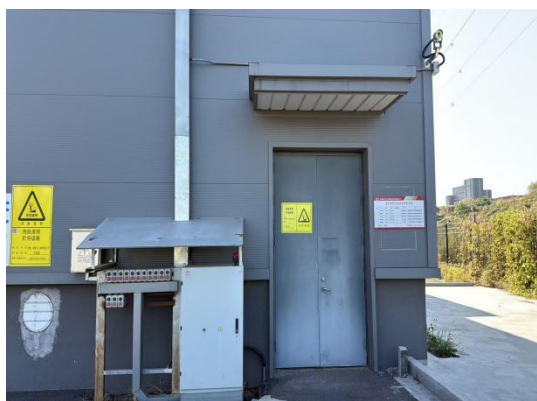
危险废物暂存间
