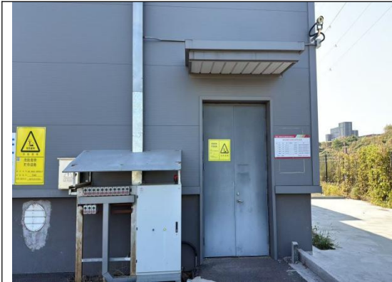
危险废物暂存间
