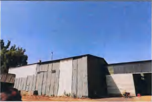
封闭车间-生产车间及原料库
