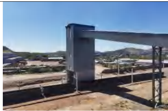
石渣卸料区域
