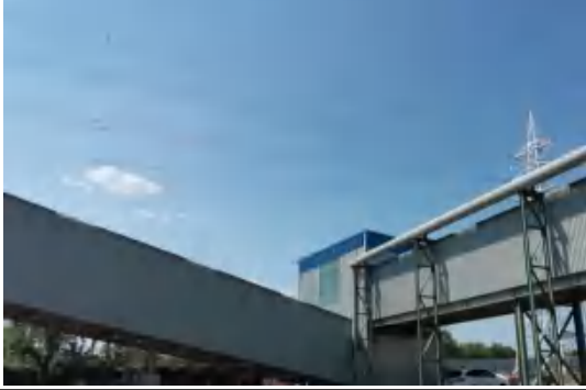
封闭转运站+收尘
