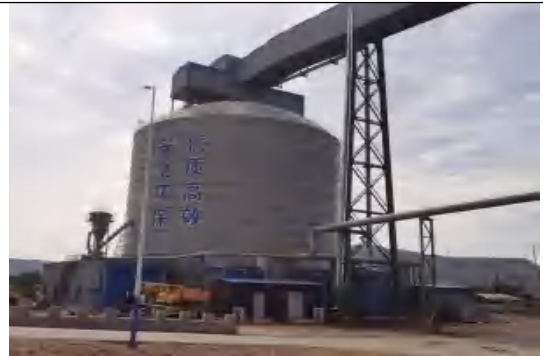
石砵料仓封闭+收尘
