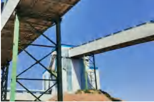
中碎车间封闭
