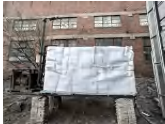
水箱（外设保温，内设加热棒）
