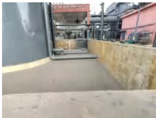
氨水储罐区围堰
