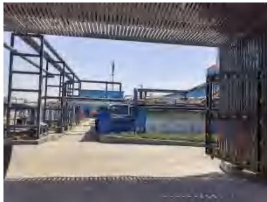
综合污水处理站
