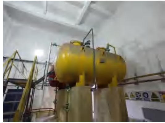
封闭酸储罐
