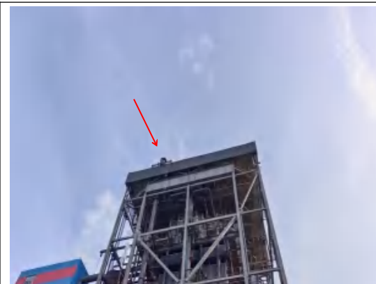
排汽孔安装小孔消音器
