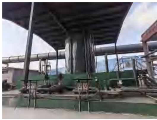
封闭氨储罐
