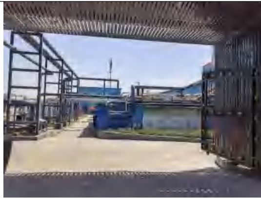
综合污水处理站
