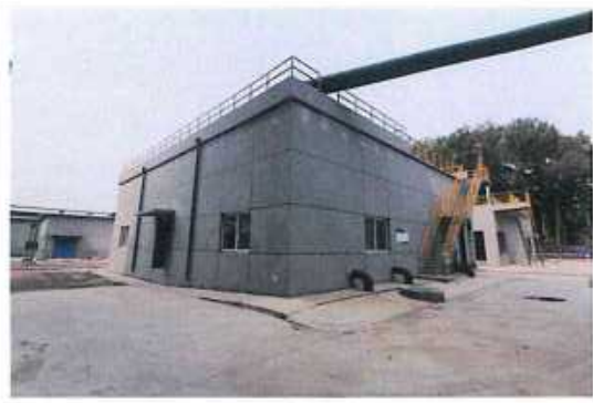
大石河废水处理系统
