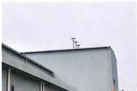
石灰仓除尘器排气筒
