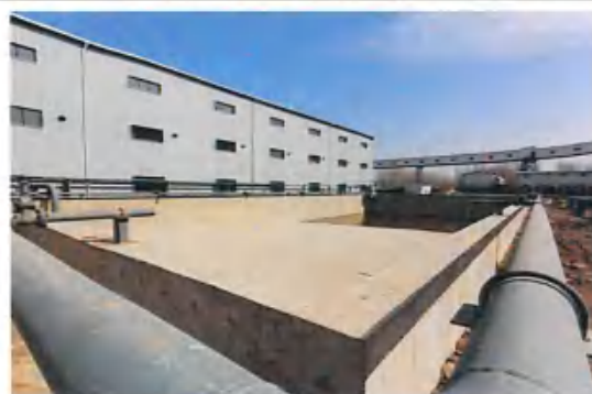
事故池-首端站
