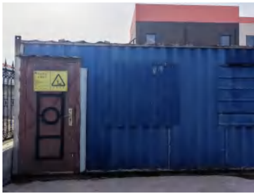
危险废物暂存间
