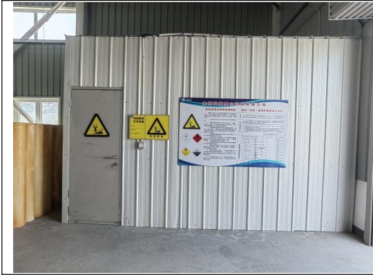
危险废物暂存间
