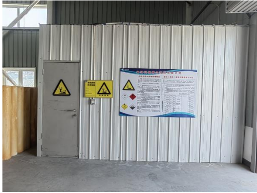
危险废物暂存间
