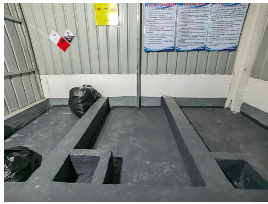
危废间内分区
