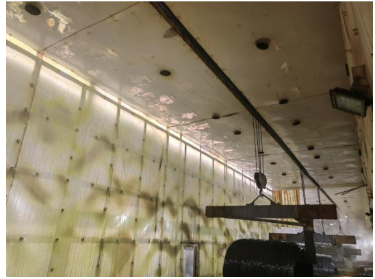
封闭酸洗房内集气口
