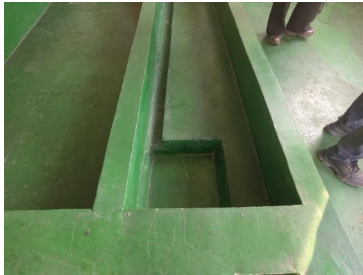
危废间集液池
