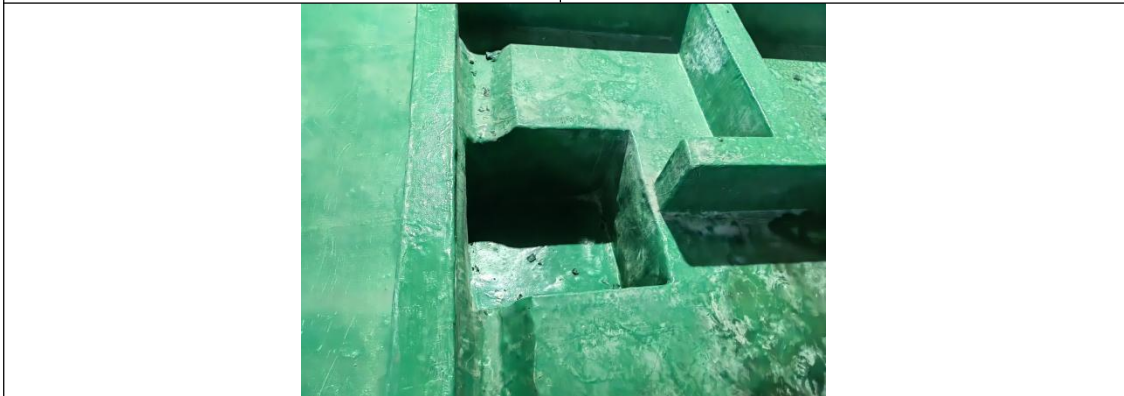
危废间集液池
