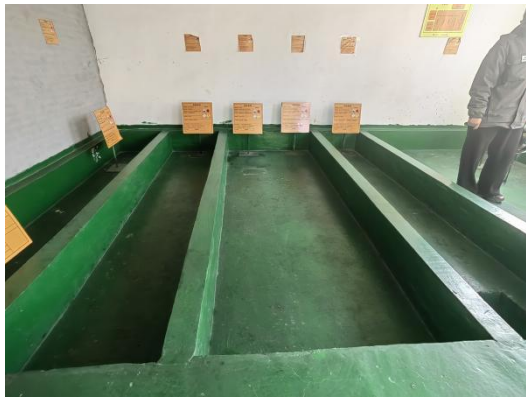
1#危险废物暂存间分区
