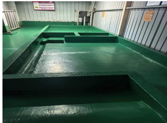
2#危险废物暂存间分区
