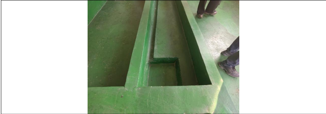
危废间集液池
