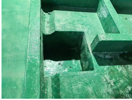
危废间集液池
