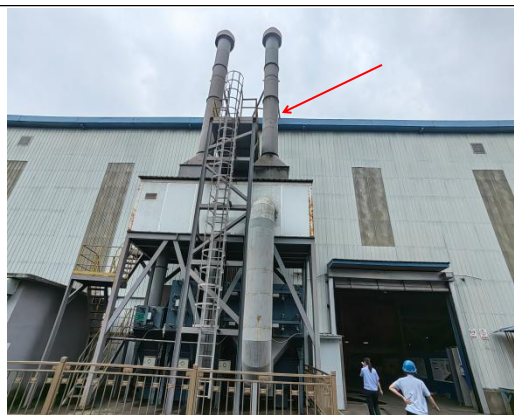
铜板修复喷涂房滤筒滤芯除尘器
