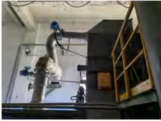
皮带机头轮卸料点集气罩
