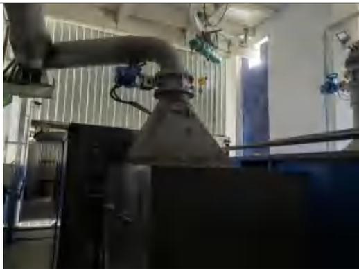
皮带机头轮卸料点集气罩
