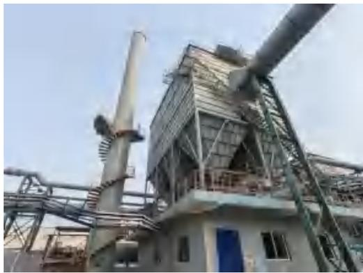
低压脉冲布袋除尘器+35m 排气筒
