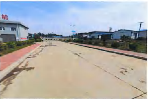
厂区道路硬化
