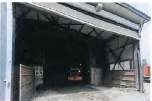
尾砂库房洗车平台
