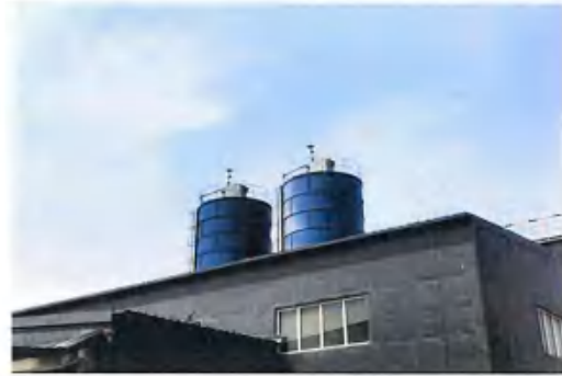
料仓+搅拌机+排气筒 (P1、P2)
