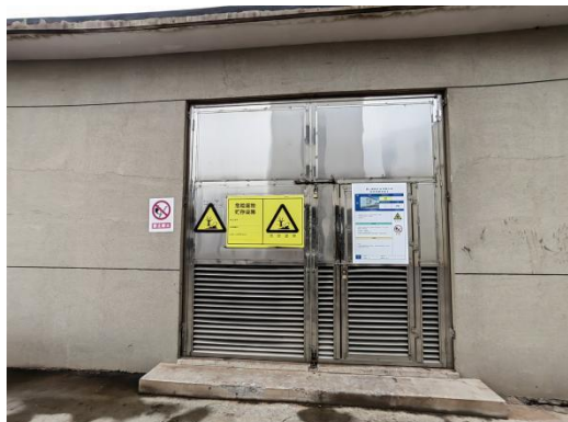
危险废物暂存间
