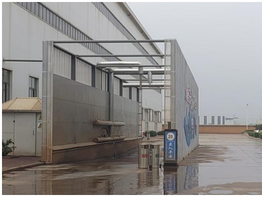
厂区内车辆洗车设施
