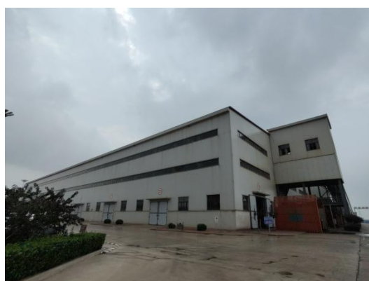
封闭精粉库房
