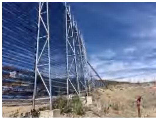
原矿堆场防风抑尘网
