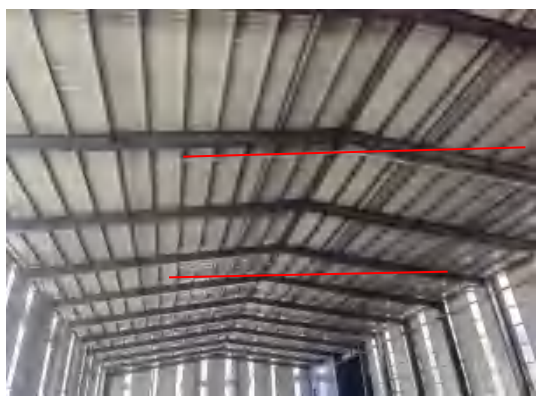
精粉库房内喷雾设施
