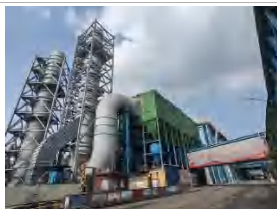
新 2#转炉三次烟气布袋除尘器+排气筒
