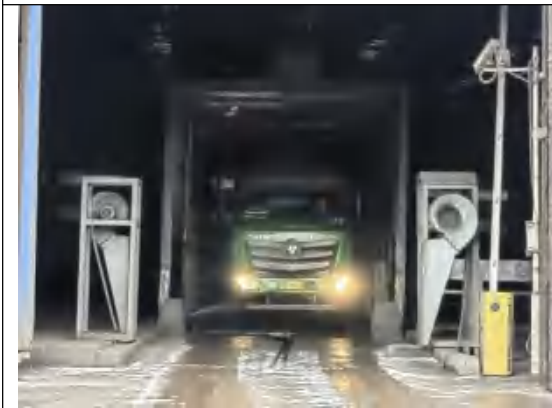
原料库门口洗车设施
