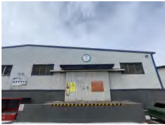
危险废物暂存间
