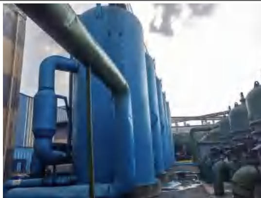
2#转炉配套连铸机化学除油
