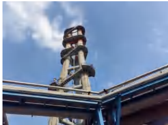
新 1#转炉散装料上料及转运工序布袋除尘器排气筒
