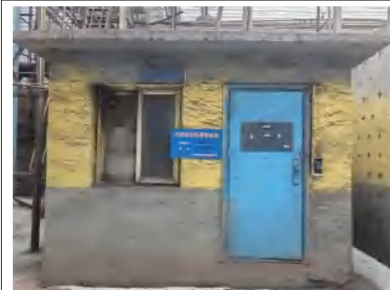
高炉矿槽排放口在线监测站
