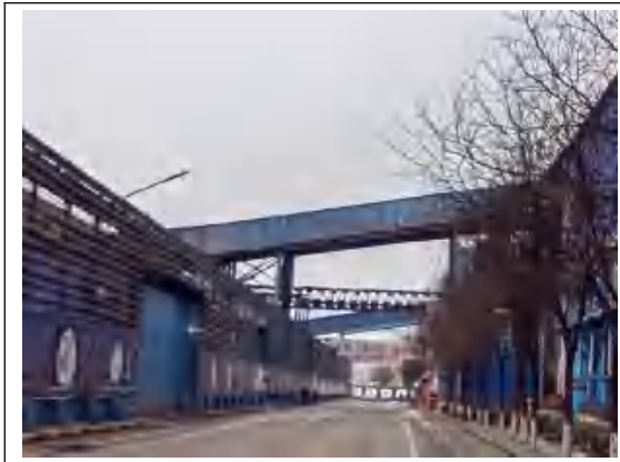
封闭皮带通廊
