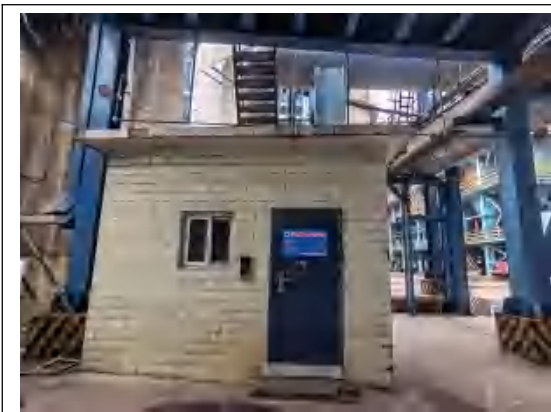
高炉热风炉排放口在线监测站
