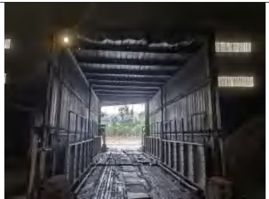
原料库门口洗车设施
