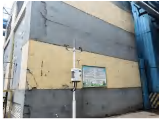
无组织废气监测设施
