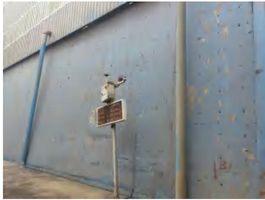
无组织废气监测设施
