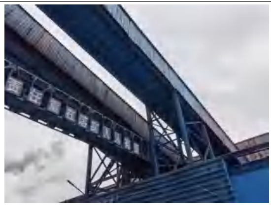
封闭皮带通廊
