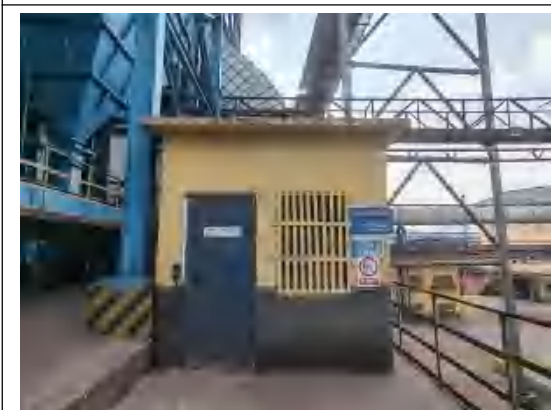
新 1#转炉三次烟气排放口在线监测站
