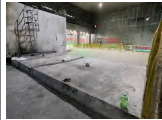
渣沟加盖封闭
