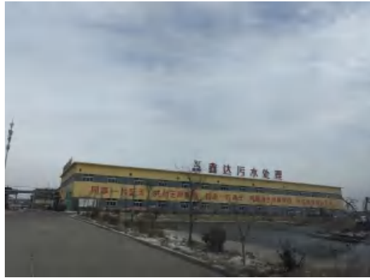
综合污水处理站
