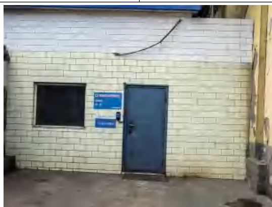
新 2#转炉三次烟气排放口在线监测站
