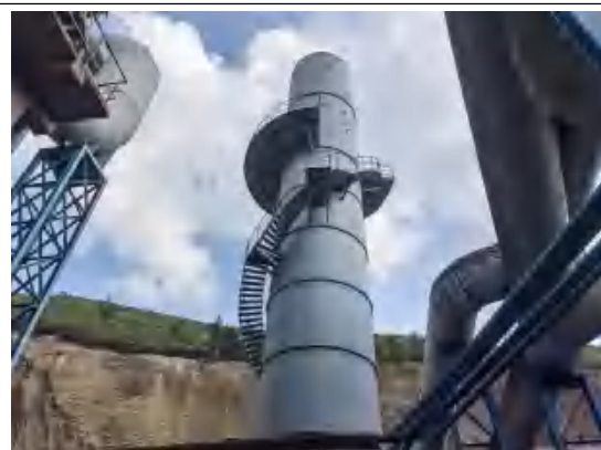
新 2#转炉二次烟气布袋除尘器排气筒
