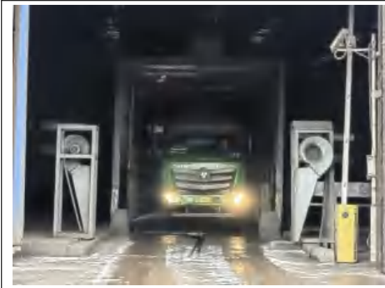
原料库门口洗车设施
