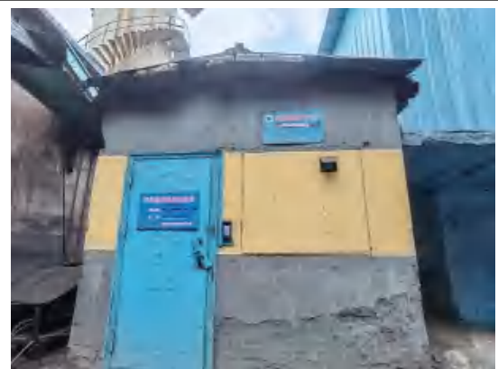
高炉出铁场排放口在线监测站
