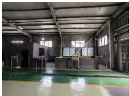
危险废物暂存间分区
