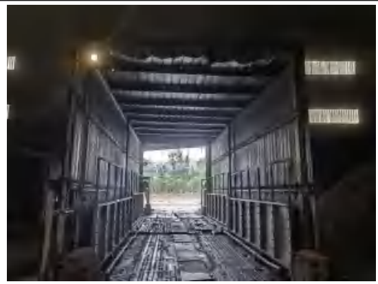
原料库门口洗车设施
