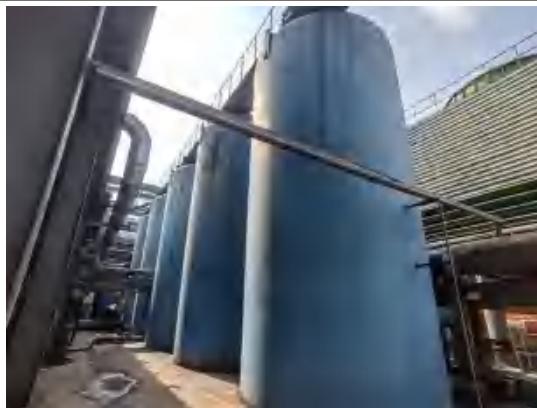
1#转炉配套连铸机化学除油
