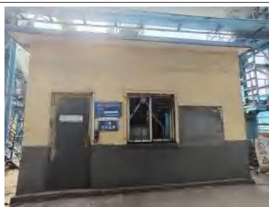
新 1#转炉二次烟气排放口在线监测站
