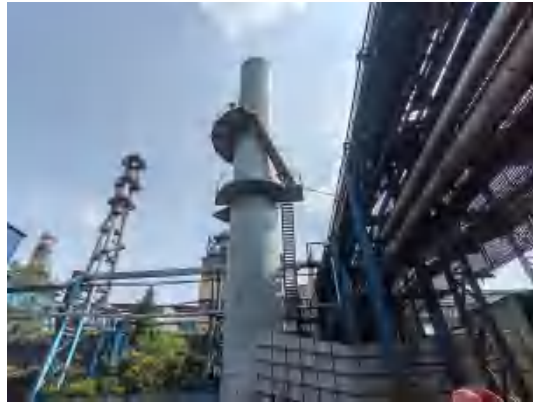
新 1#转炉散装料上料及转运工序布袋除尘器排气筒
