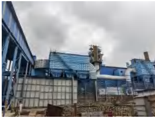
炉顶布料废气布袋除尘器
