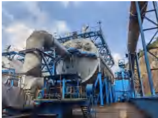
新 1#转炉散装料上料及转运工序布袋除尘器排气筒
