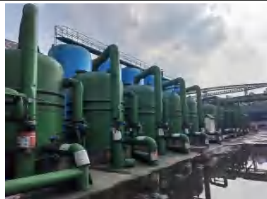
2#转炉配套连铸机双旋流过滤器
