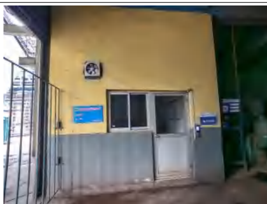
新 2#转炉二次烟气排放口在线监测站
