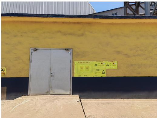
危险废物暂存间
