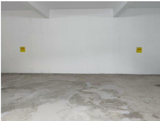
危险废物暂存间分区
