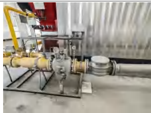
燃气管道安全阀、截止阀
