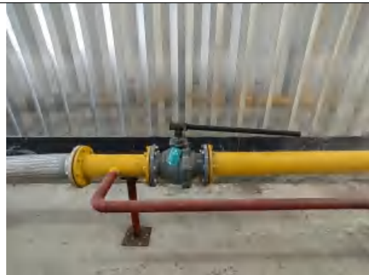
燃气管道安全阀、截止阀
