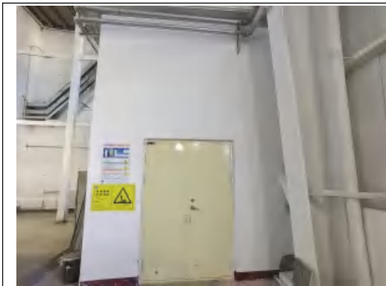
危险废物暂存间
