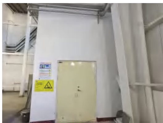
危险废物暂存间
