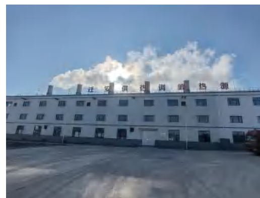
锅炉排气筒（5根）
