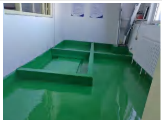
危险废物暂存间分区
