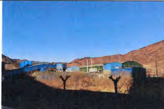
固废处理线-破碎、筛分
