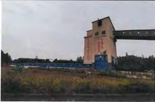
皮带通廊起点
