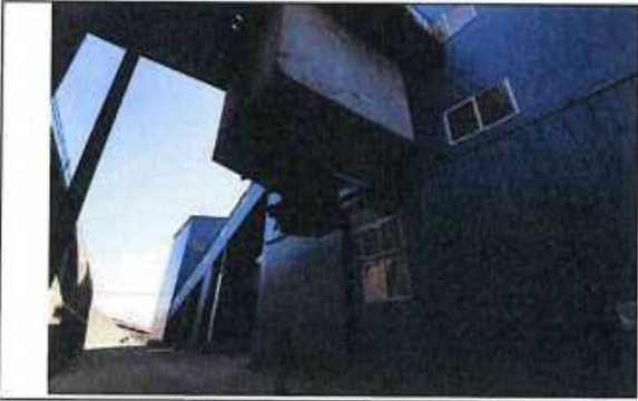
新增高压辊磨车间及筛分车间
