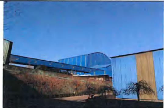
皮带通廊终点
