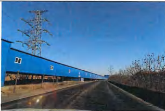
露天采坑西侧皮带通廊
