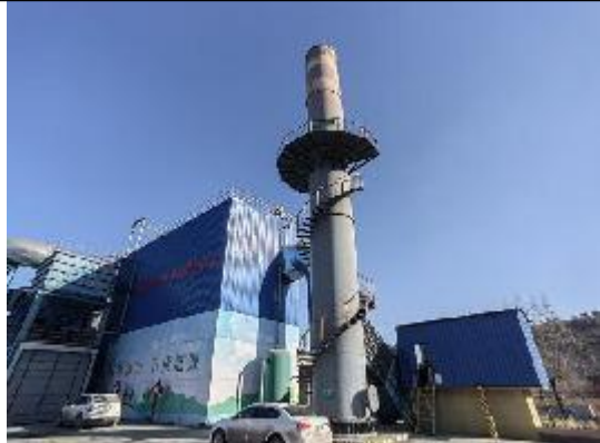
脉冲布袋除尘器+排气筒
