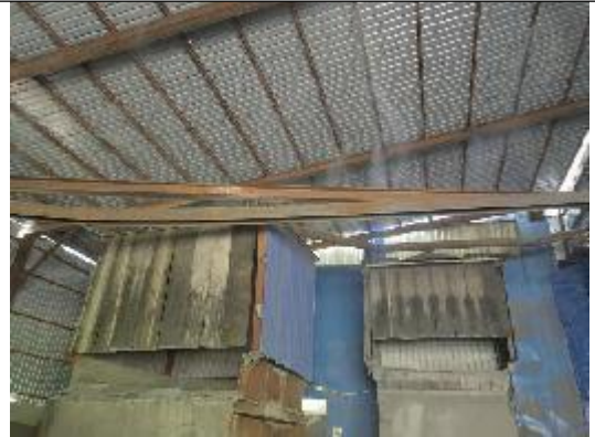
上料口设置软帘+喷淋+集气罩
