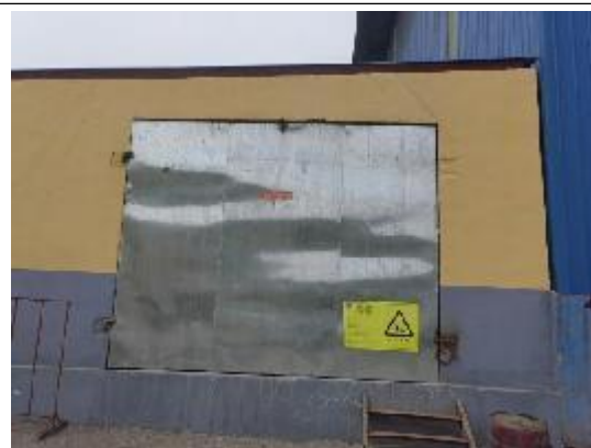
危险废物暂存间
