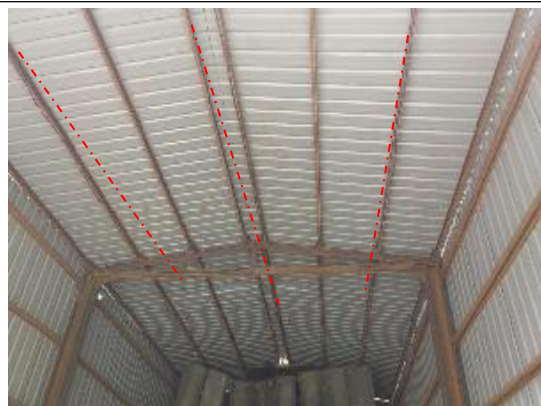
南侧上料仓喷淋设施
