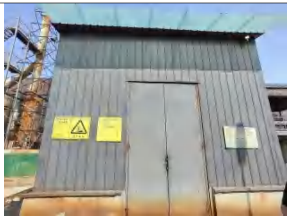
2#危险废物暂存间
