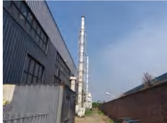
酸雾吸收塔 22m 高排气筒
