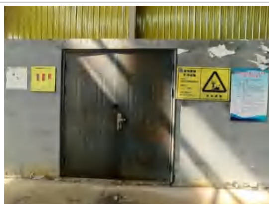
1#危险废物暂存间
