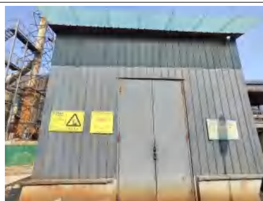
2#危险废物暂存间
