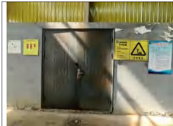
1#危险废物暂存间
