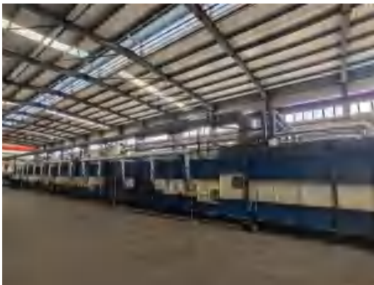
热处理炉低氮燃烧
