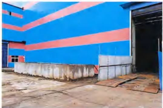
洗车废水沉淀池
