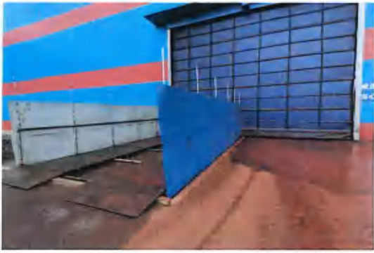
库房出口洗车平台
