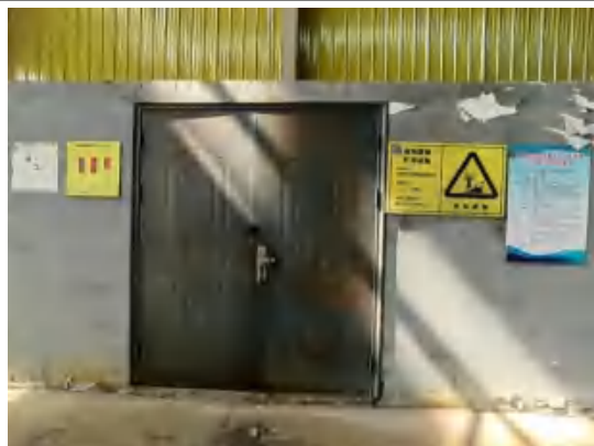
1#危险废物暂存间
