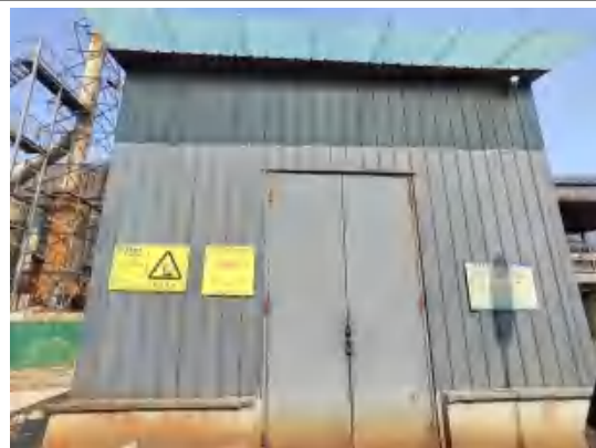
2#危险废物暂存间
