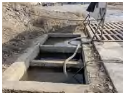
洗车台沉淀池
