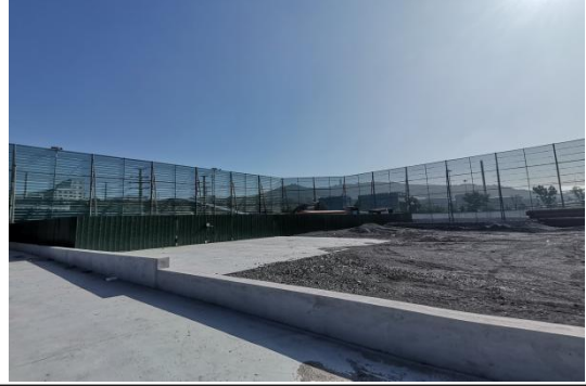
南侧新建临时堆场
