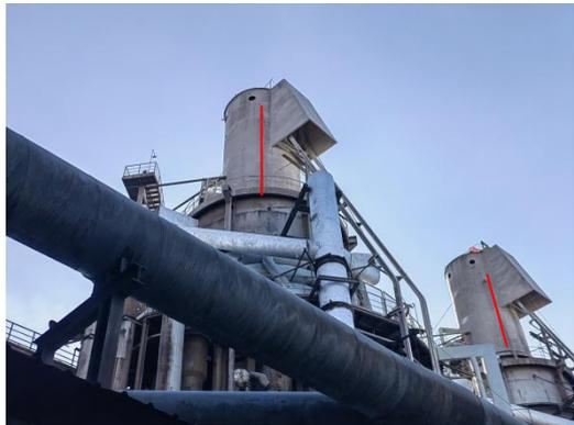
窑顶料车卸料废气收集管道
