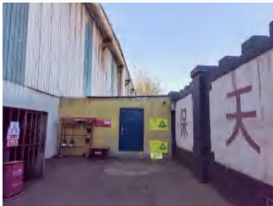
危险废物暂存间
