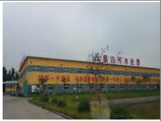
鑫达污水处理站
