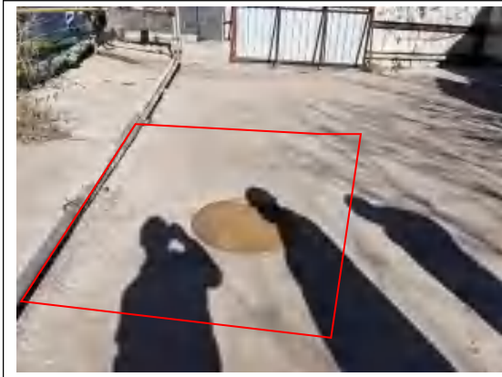
生活污水收集池
