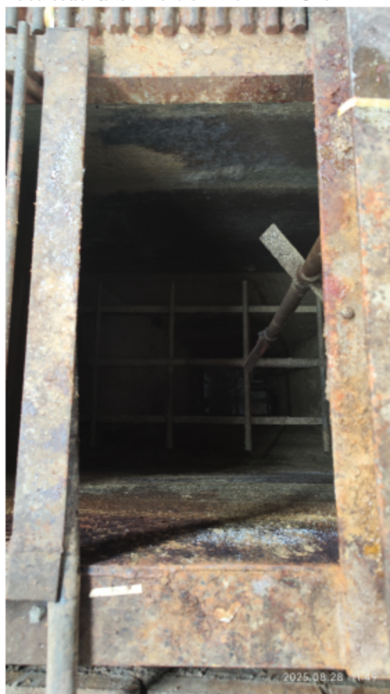
图 4 废水处理设施照片
