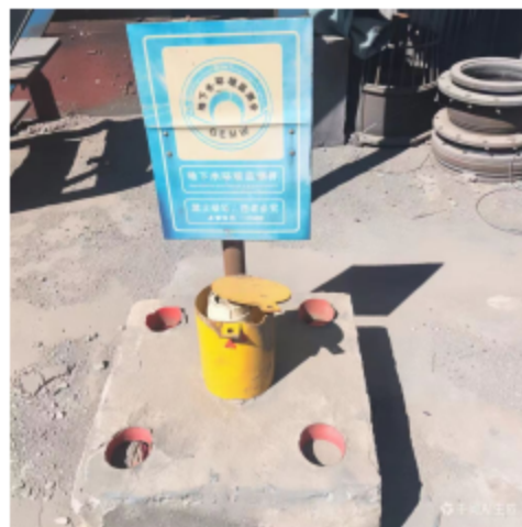
图 5 应急池及地下水监测井照片
