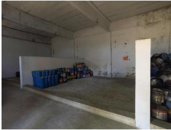
危废间分区+围堰
