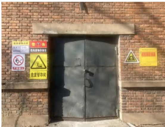
危险废物暂存间
