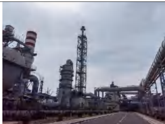
70m 高排气筒
