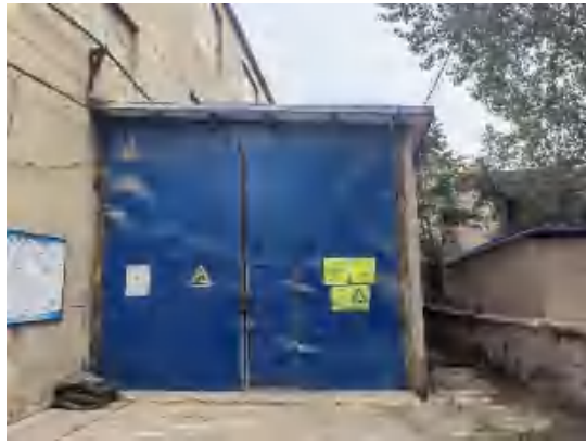
危险废物暂存间
