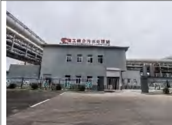
全厂污水处理站
