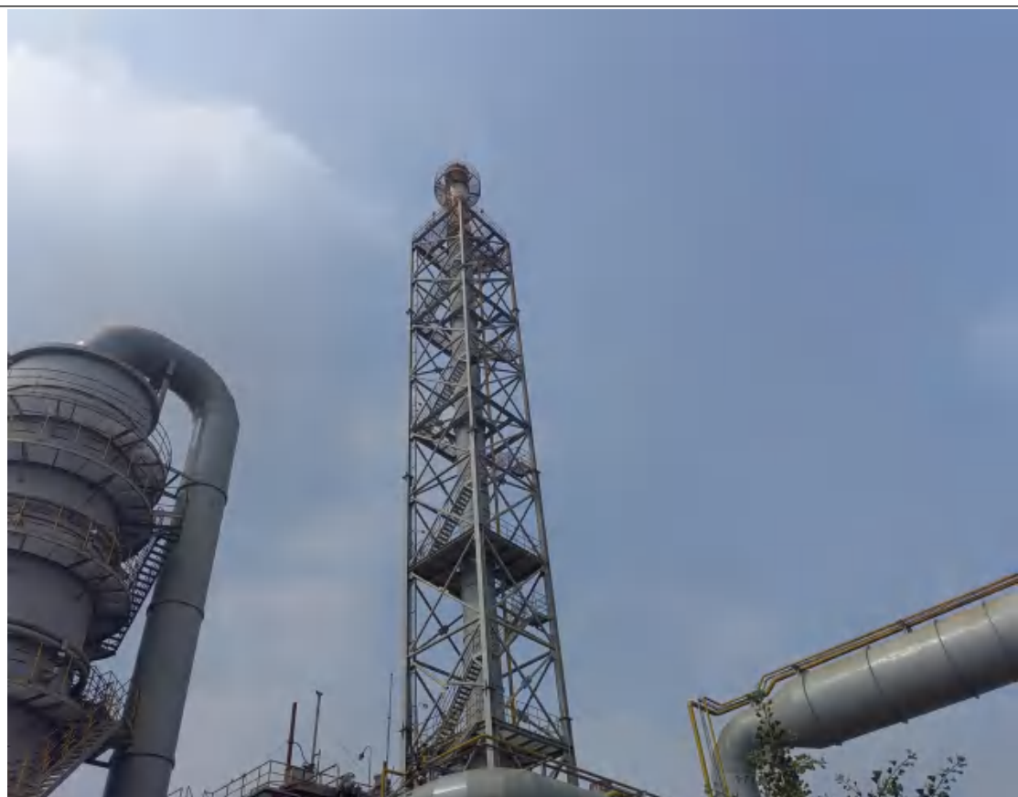
转炉一次烟气排放口
