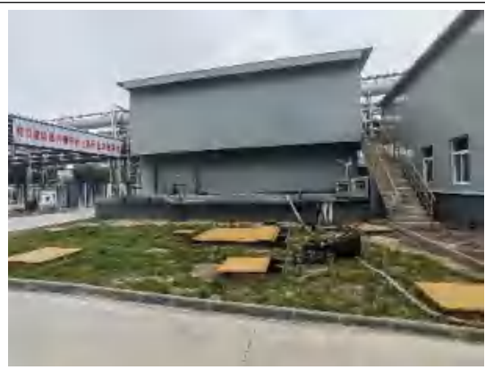
絮凝沉淀+A 2 /O水池
