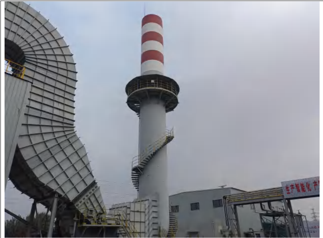
连铸及上料废气排放口
