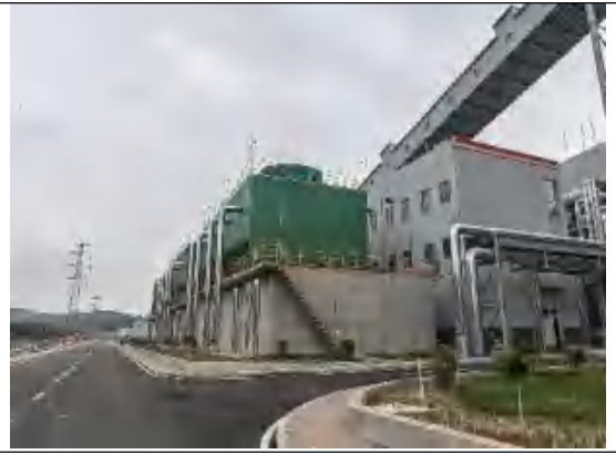
冷却循环水池
