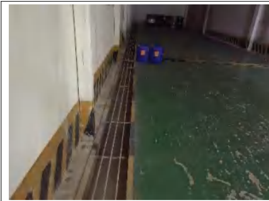
危废间导流沟
