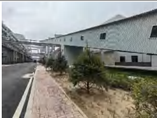
封闭皮带通廊
