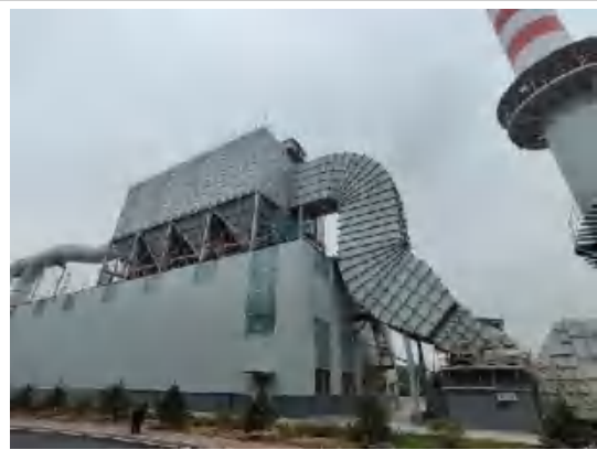
连铸及上料脉冲布袋除尘器
