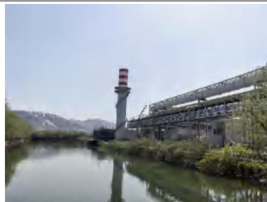
二次烟气除尘器 40m 高排气筒
