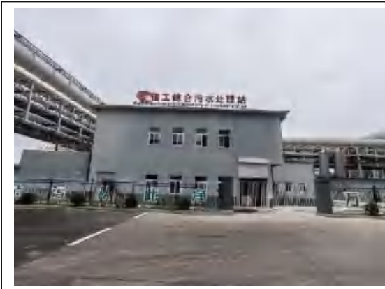
全厂污水处理站
