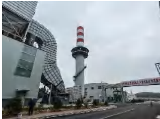
连铸及上料脉冲布袋除尘器 35m 排气筒
